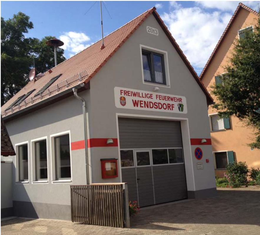
2011 wurde das Erdgeschoss fertig gemauert, die Decke betoniert und die Giebel aufgemauert. Anschließend wurden die Treppenfertigteile gesetzt, der Dachstuhl aufgerichtet, Richtfest gefeiert und anschließend Dach gedeckt. Insgesamt waren bis dahin schon 640 Stunden Eigenleistung durch die Feuerwehrkameradinnen und Kameraden angefallen.
