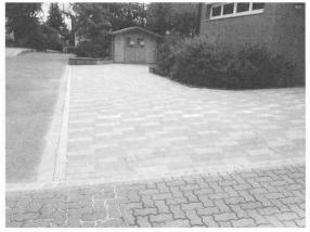
und dem Eingang zum Hort Sonnenblick waren Setzungen im Asphalt und vermehrt auch Abplatzungen im Pflasterbelag festzustellen. Dadurch konnte das Regenwasser nicht mehr vollständig abfließen und es blieben immer wieder Pfützen zurück, die letztendlich zu den Schäden an Pflaster und Asphalt führten. Diese Arbeiten konnten nun termingerecht noch weit vor dem Beginn des neuen Schuljahres fertiggestellt werden, womit wieder ein ordnungsgemäßer Zustand der Außenanlagen hergestellt werden konnte.
